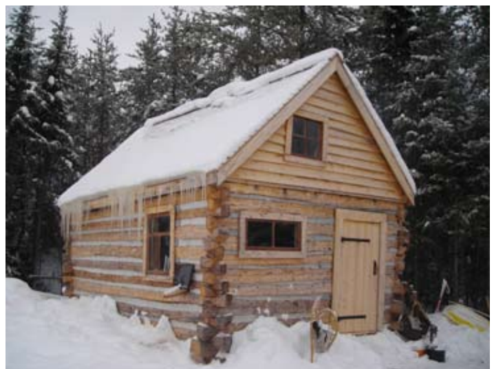
2007, construction d'une cabane en bois rond du XIX e siècle
